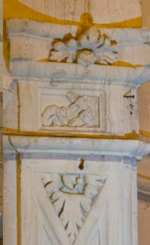
Saint-Maurice, détail d'un chapiteau Renaissance
