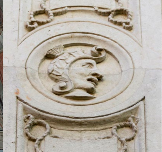
Maison éclectique, médaillon, détail de la façade
