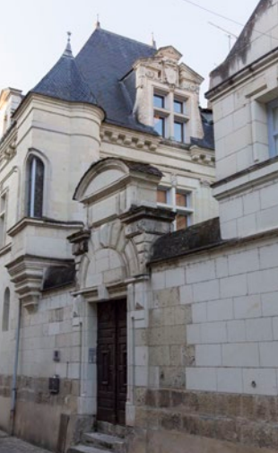
Maîtrise des Eaux et Forêts, façade sur rue
