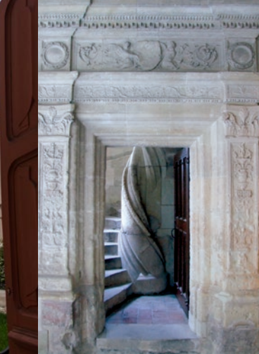
Cloître de la Psalette, porte desservant l'escalier en vis à l'angle des ailes nord et est
