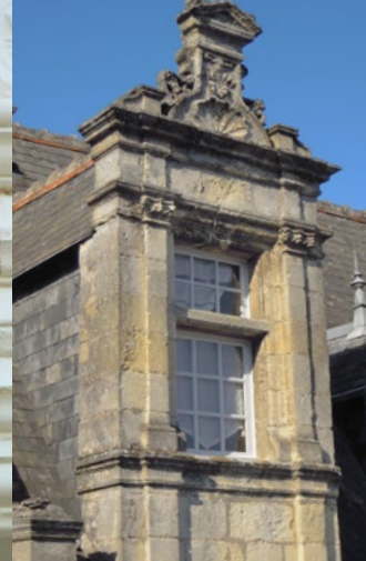
Lucarne du presbytère à pilastres et chapiteaux corinthiens
