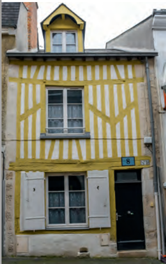
La 1000 e façade restaurée, au 8 rue Croix-de-Bois.
