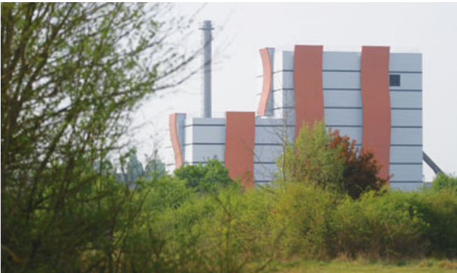
La 2 e chaufferie biomasse d'Orléans, en fonction depuis cette année.
