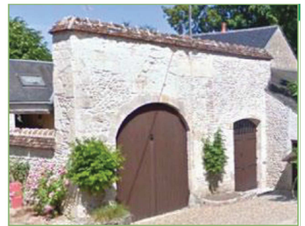
MUR AVEC PORCHE
