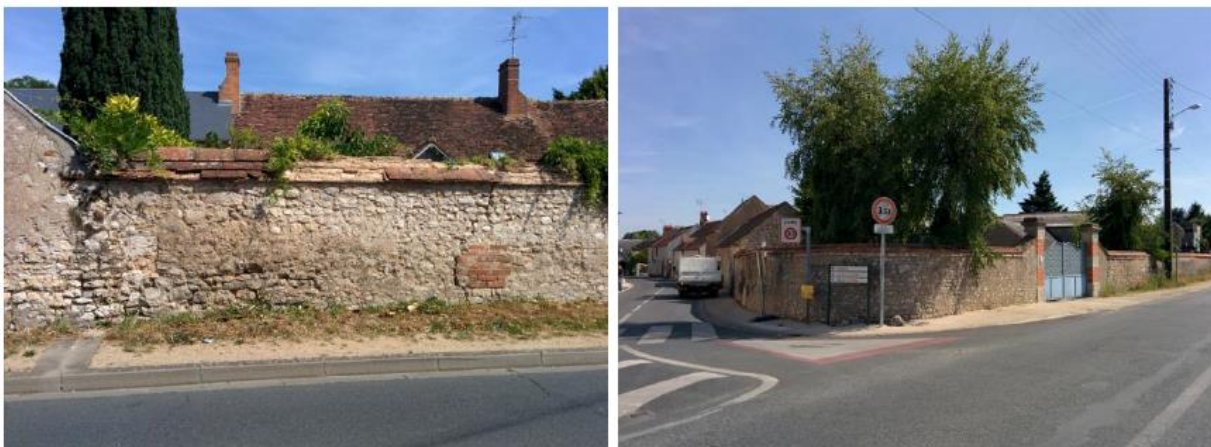
Murs en moellons enduits au 769 Route d'Olivet (Source : AUAO, 2015)
