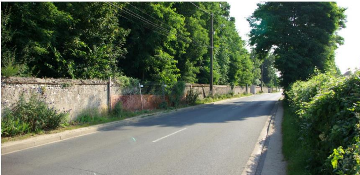
Mur en moellons enduits au 325 Route d'Olivet (Source : AUAO, 2015)
