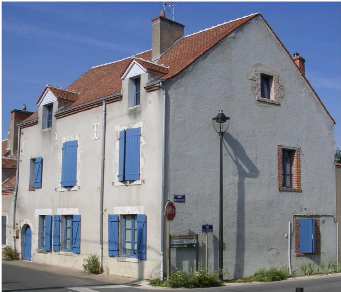
Façade méridionale (Cliché Ph. Derrien, 2009)
