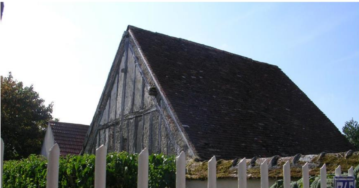
Pignon à colombage, 2009
