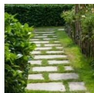
Pavés à joints enherbés
