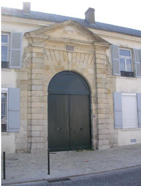
Façade route d'Orléans, 2009
