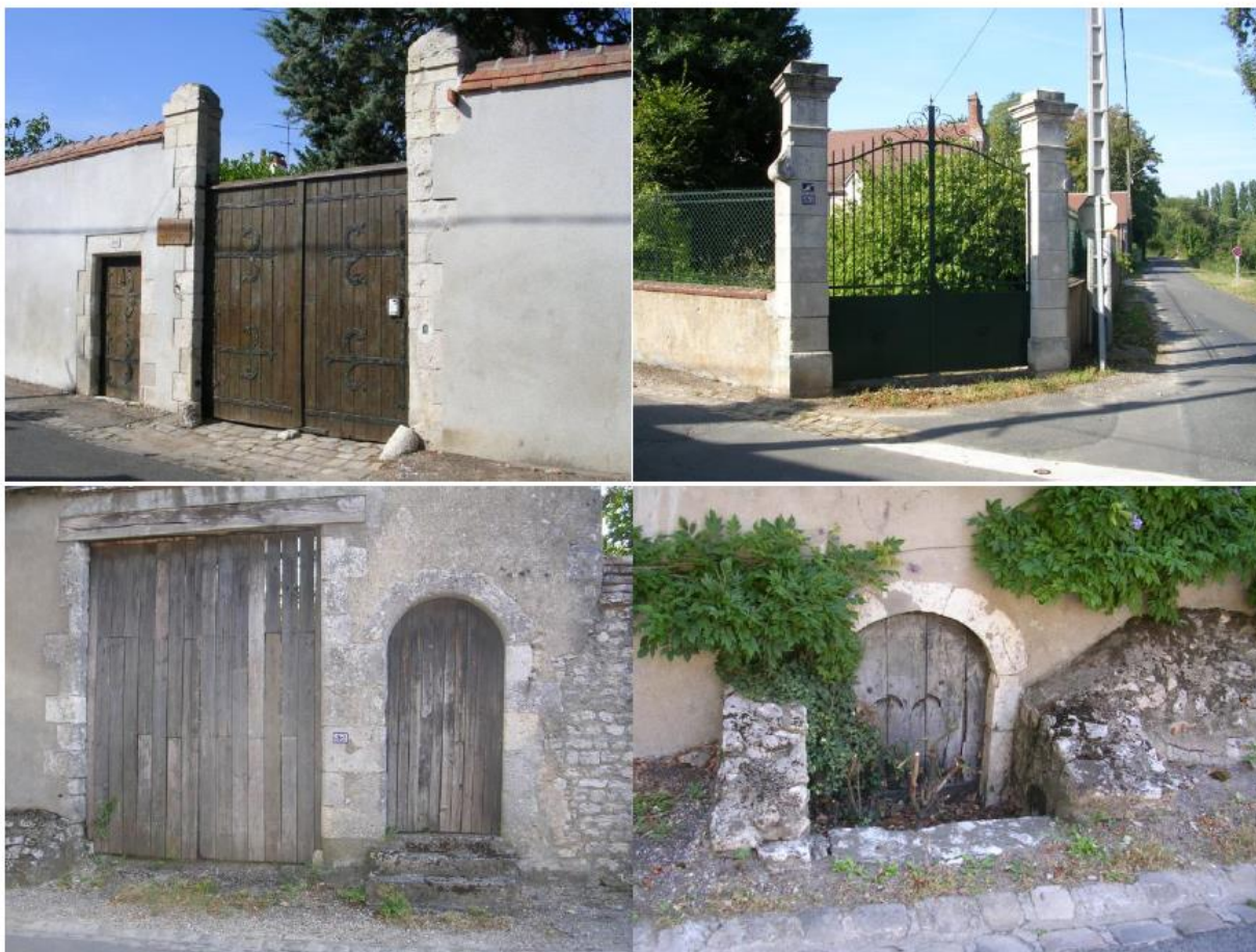
Portes de la rue des Vaslins, 2009
