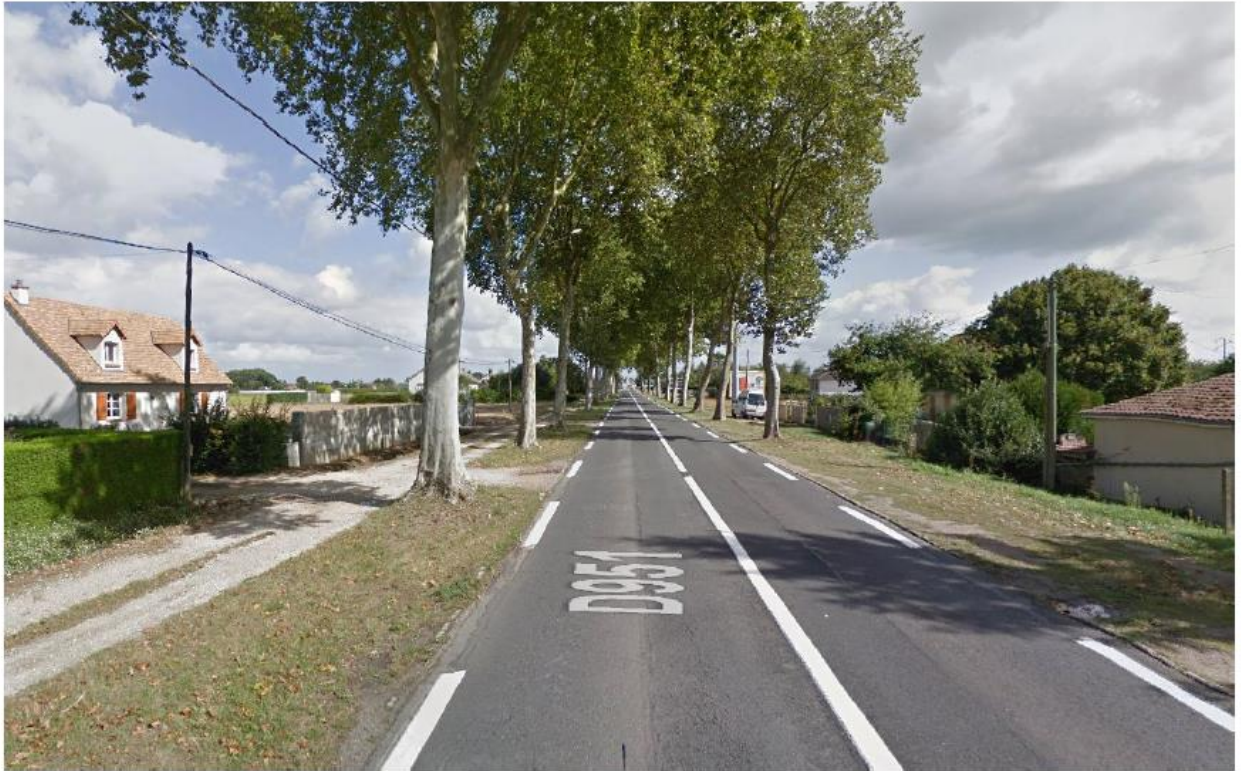
Alignement de platanes (Source : Google street view, 2013)
