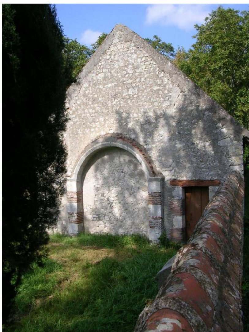
Grange avec arcature extérieure, 2009
