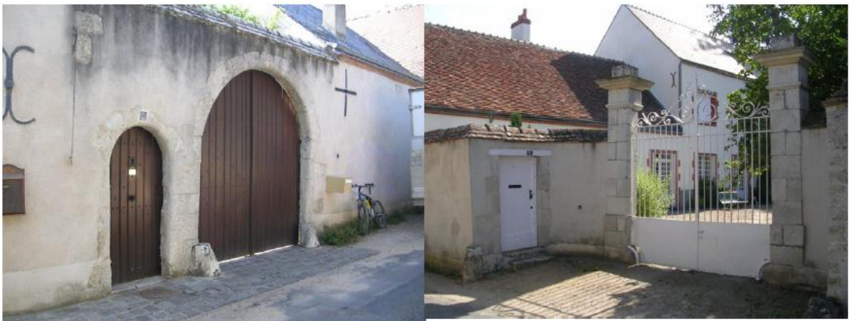
Entrée de propriétés rue du Bouillon, 2009
