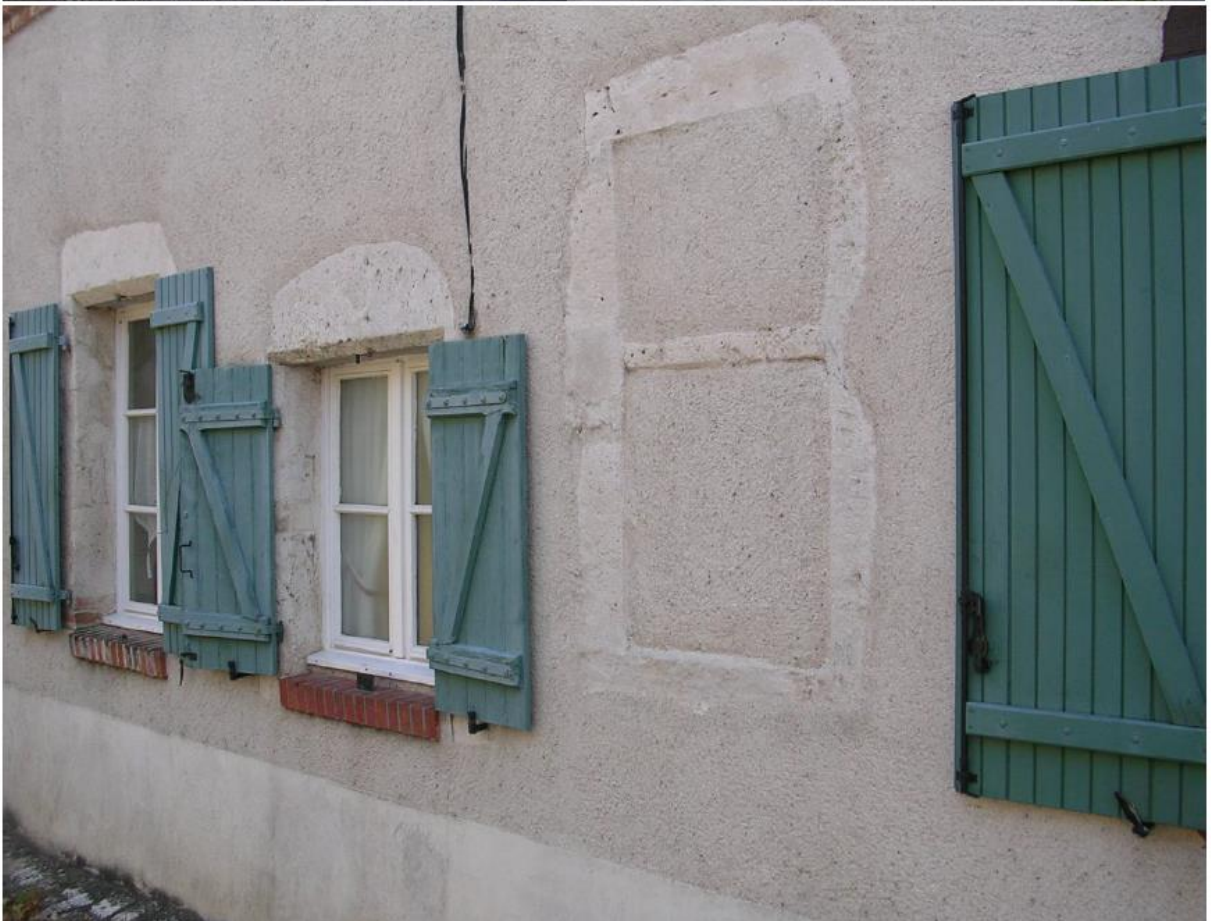
Portes et fenêtres de la rue des Vaslins, 2009
