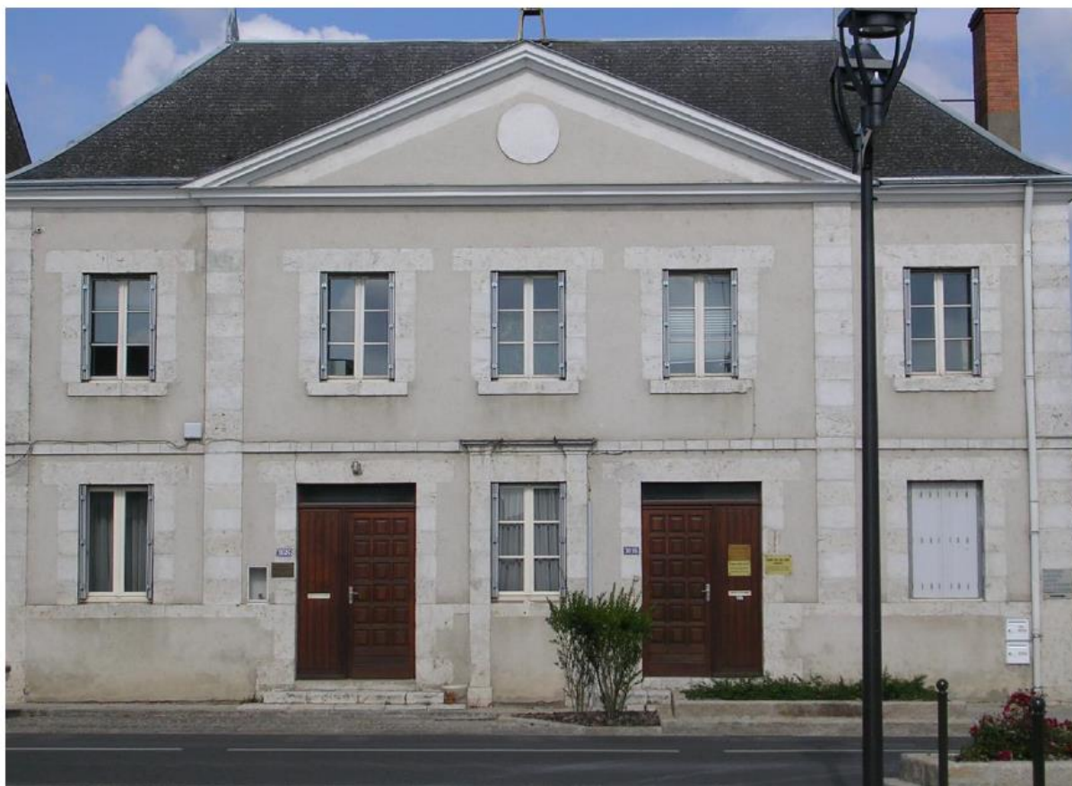
Façade 1016 route d'Orléans, 2009
