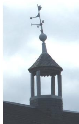
Détail de la toiture (Cliché Ph. Derrien, 2009)
