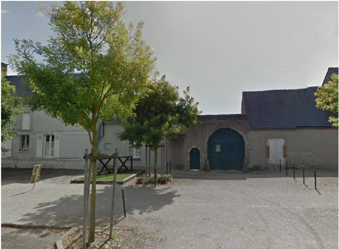
Porte cochère (Source : Google street view, 2013)
