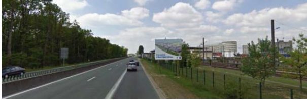
4 - Carrefour de Verdun marqué par l'enchevêtrement et la largeur des espaces
