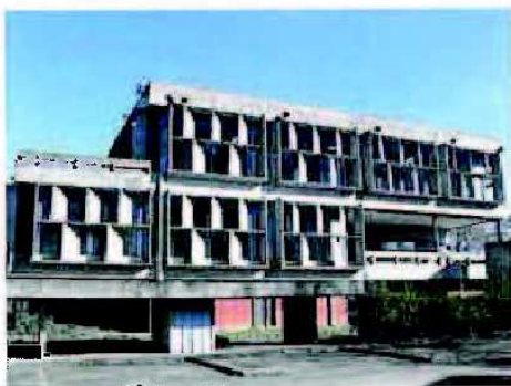
Façade sud (rue Paul Langevin)
