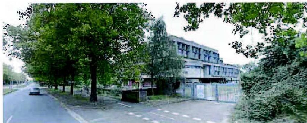
Photo 3 : Vue de l'accès principal (Avenue Claude Guillemin)
